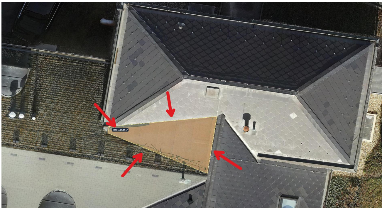
Obrázek 6: Změření plochy pro výměnu střešní krytiny
